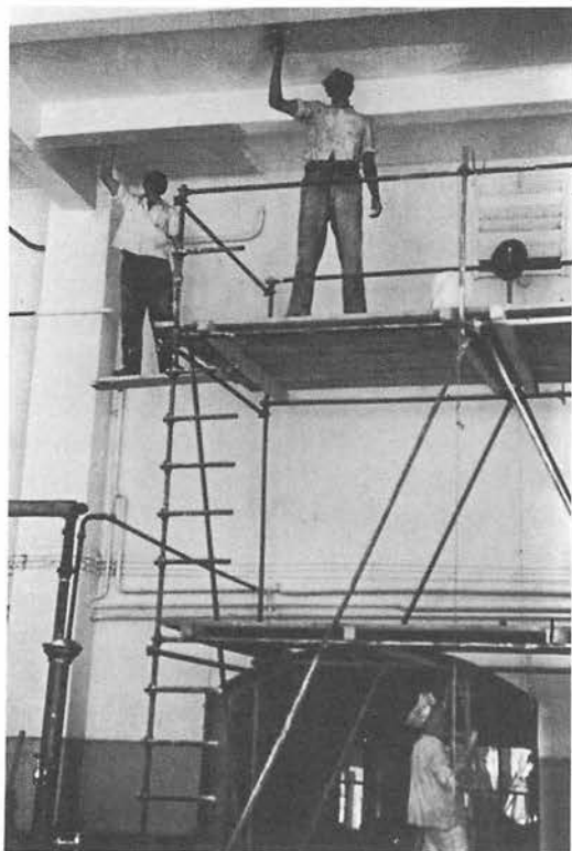
Malerarbeiten in der Küche
