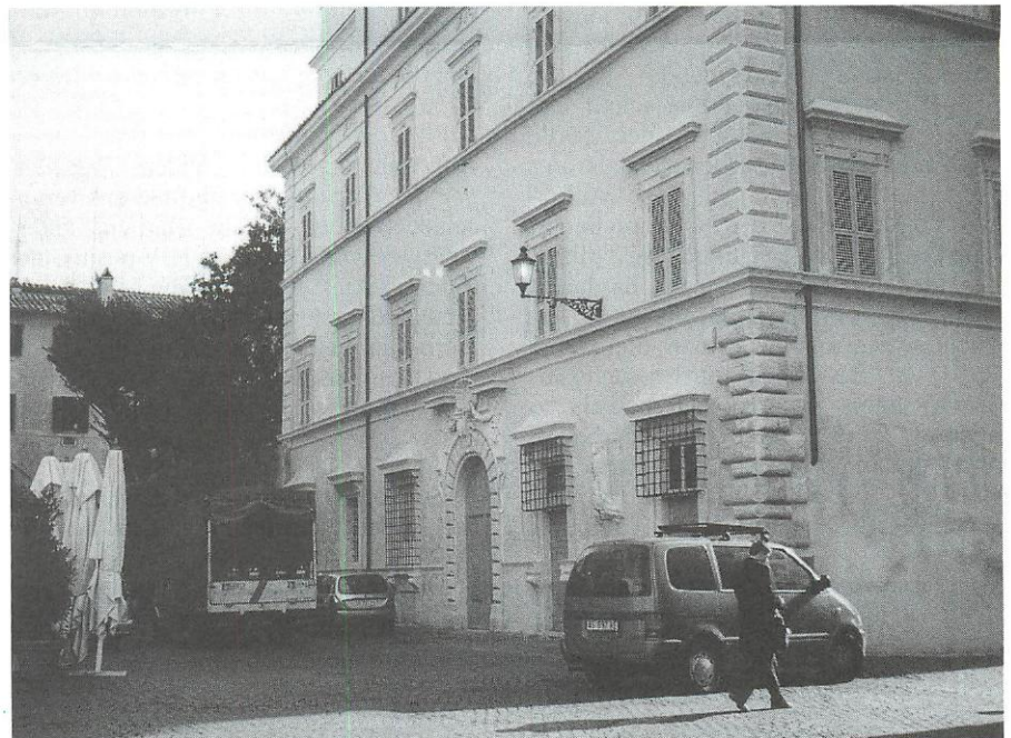
«Unser Haus», renoviert von der Gemeinschaft.
