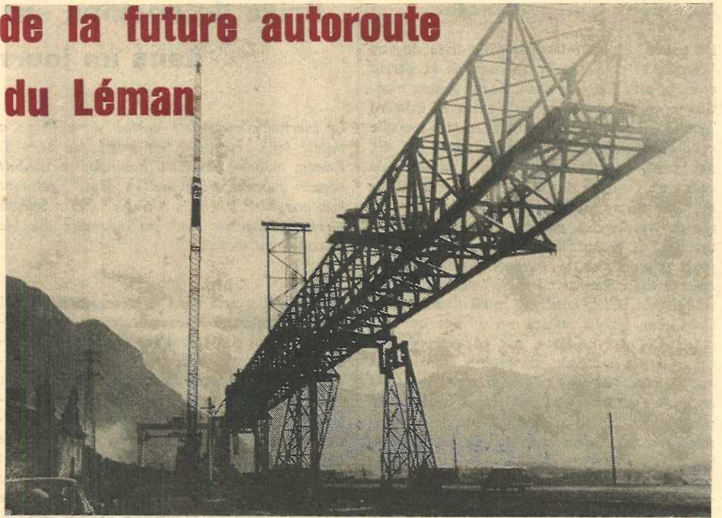
« L'araignée », atout majeur aux mains des constructeurs de l'autoroute
