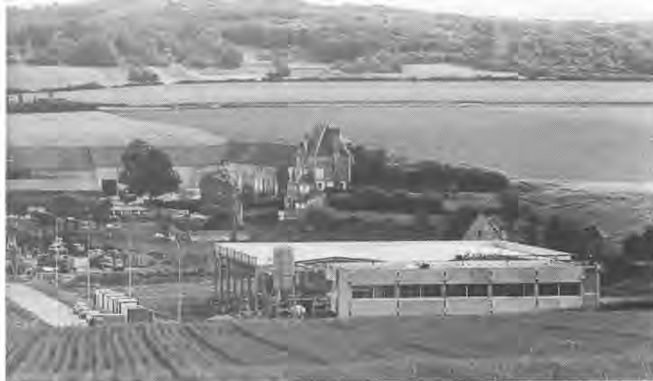
Environnement : « Plutôt que d'agrandir une vieille usine, en construire une autre ailleurs. » Une petite unité en Ile-de-France.
