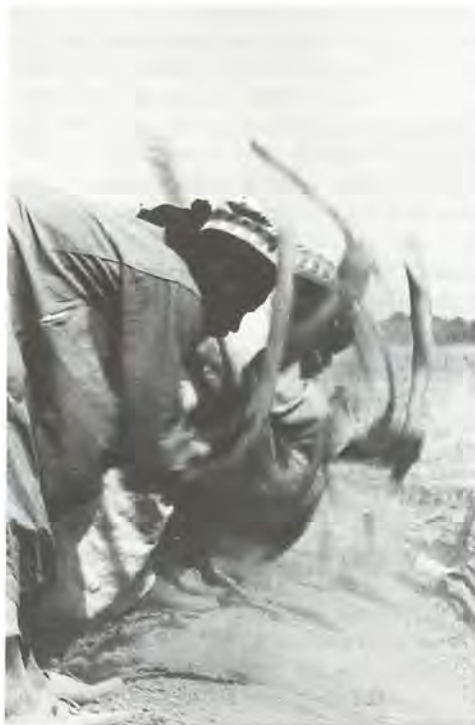
La lutte contre la sécheresse : des paysans de Haute-Volta consolident une digue en la frappant de leur seul outil : un bâton.
