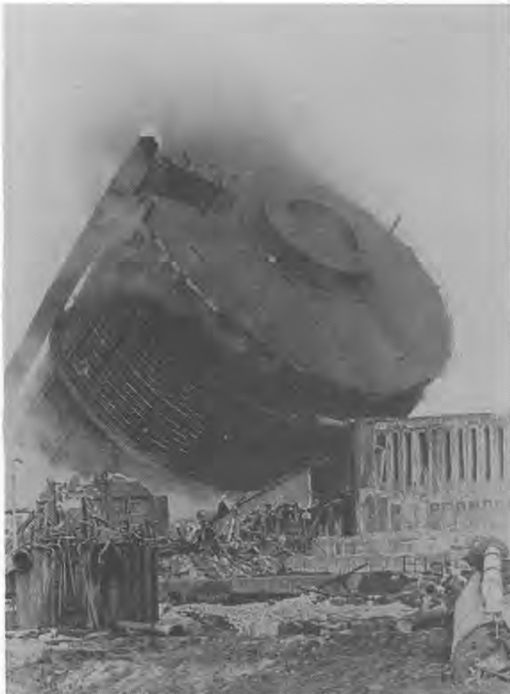
Le contrat de démolition de l'aciérie fermée a été en partie confié à la coopérative C.C.E., ce qui a fourni un emploi à une cinquantaine d'hommes. Notre photo : la fin du gazomètre.
