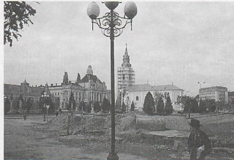
Strassen voller Schlaglöcher
