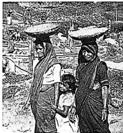
Också kvinnorna arbetar som byggnadsarbetare Dessa två bar cement i korgarna på sina huvuden
