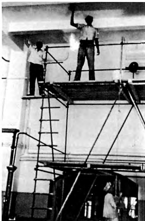
Freiwillige geben der demolierten Küche ein neues Gesicht (1947)
